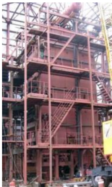
Котел компанії "Енергомашпроект"
