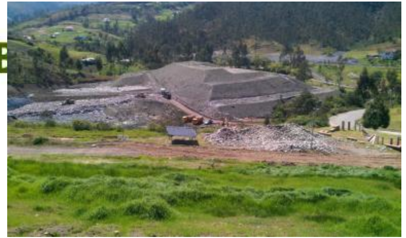
Біогаз зі звалищ + виробництво електроенергії
